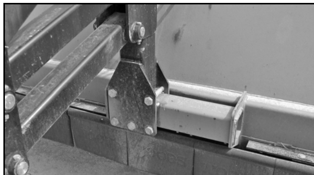
Figura 46. Colunas do suporte instaladas
